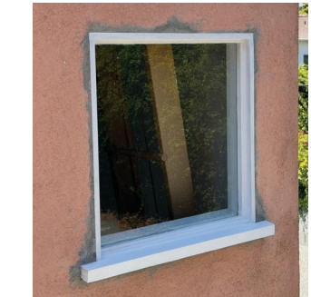
Patching the stucco.
